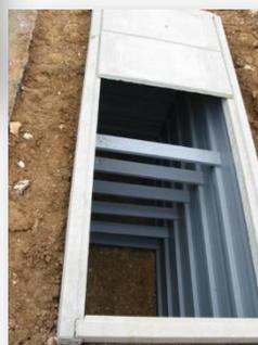
Cadre de terminaison béton avec bouchon
